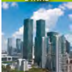
Automatizace budov a HVAC
