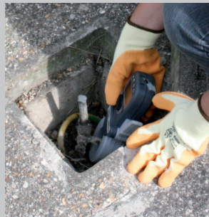
Eliptické provedení čelistí zlepšuje přístup
